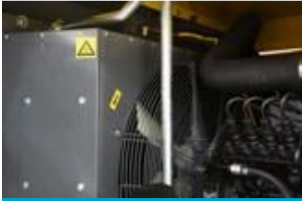
Sistema de resfriamento aprimorado para temperaturas ambientes de até 50°C.
